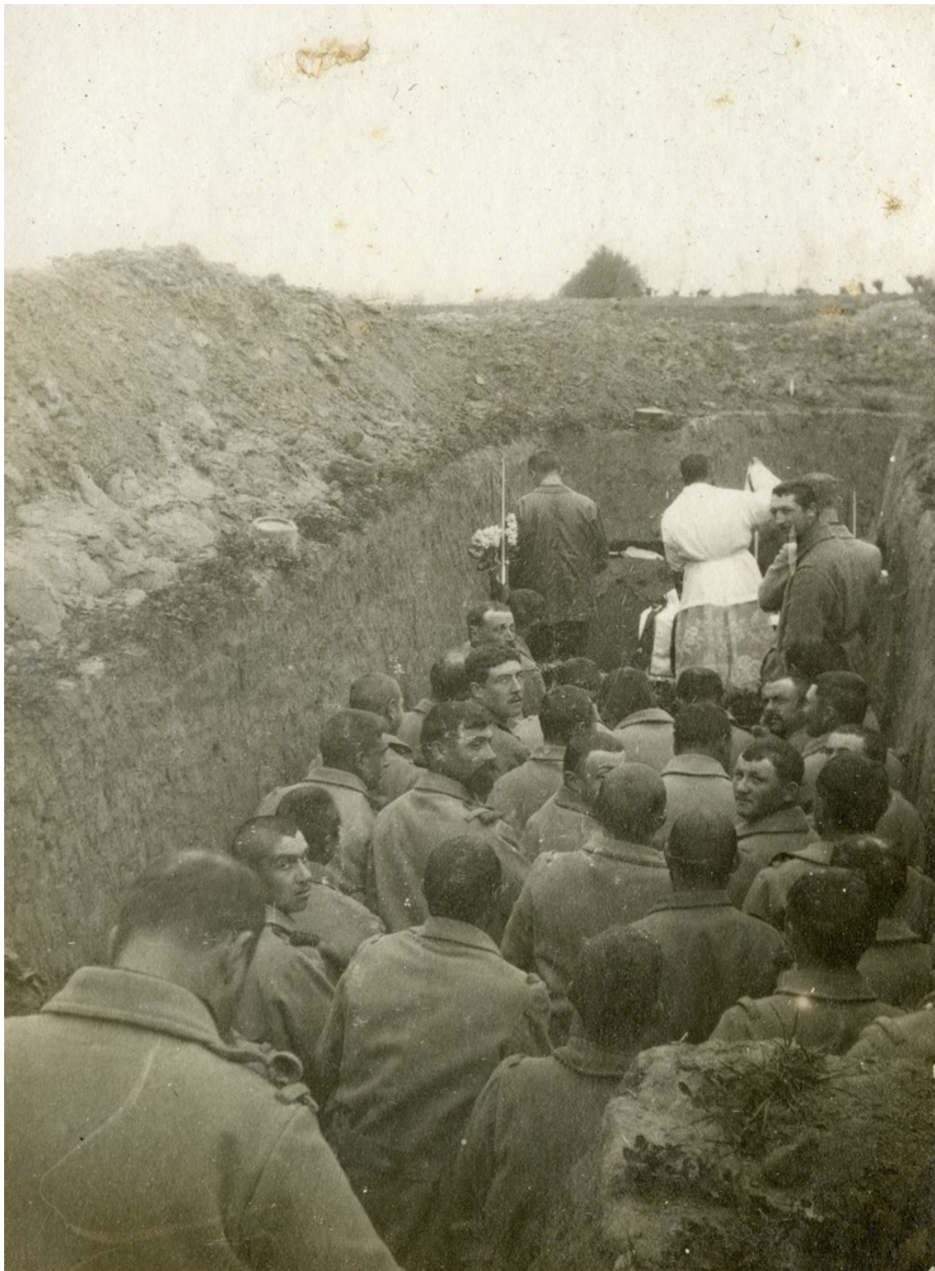
Messe dans une tranchée à Hébuterne
