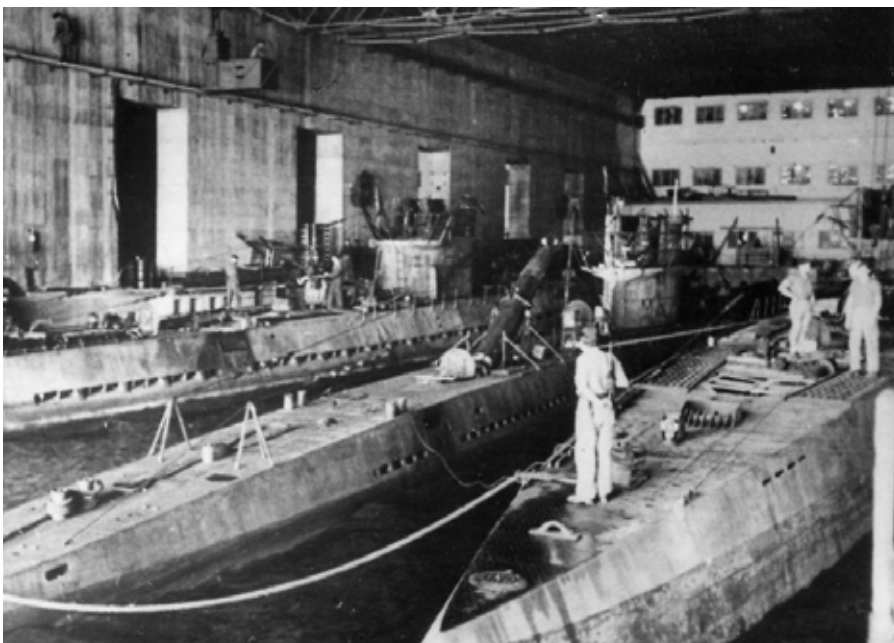
Des sous-marins dans un bassin du K3.
