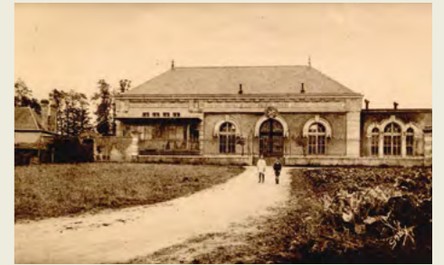
Au début du 20 e siècle est adjoint au réservoir du Petit Paradis une usine de traitement de l'eau par l'ozone. Carte postale, début du 19 e siècle, Archives municipales de Lorient.
