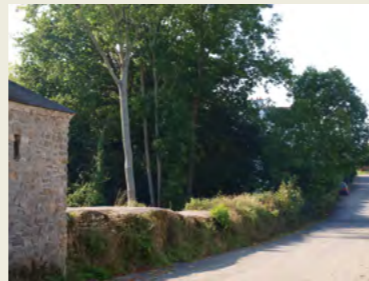
Vestige de la branche de Kerform, l'aqueduc de pierre de la Compagnie forme aujourd'hui clôture dans la rue Duliscouët.
