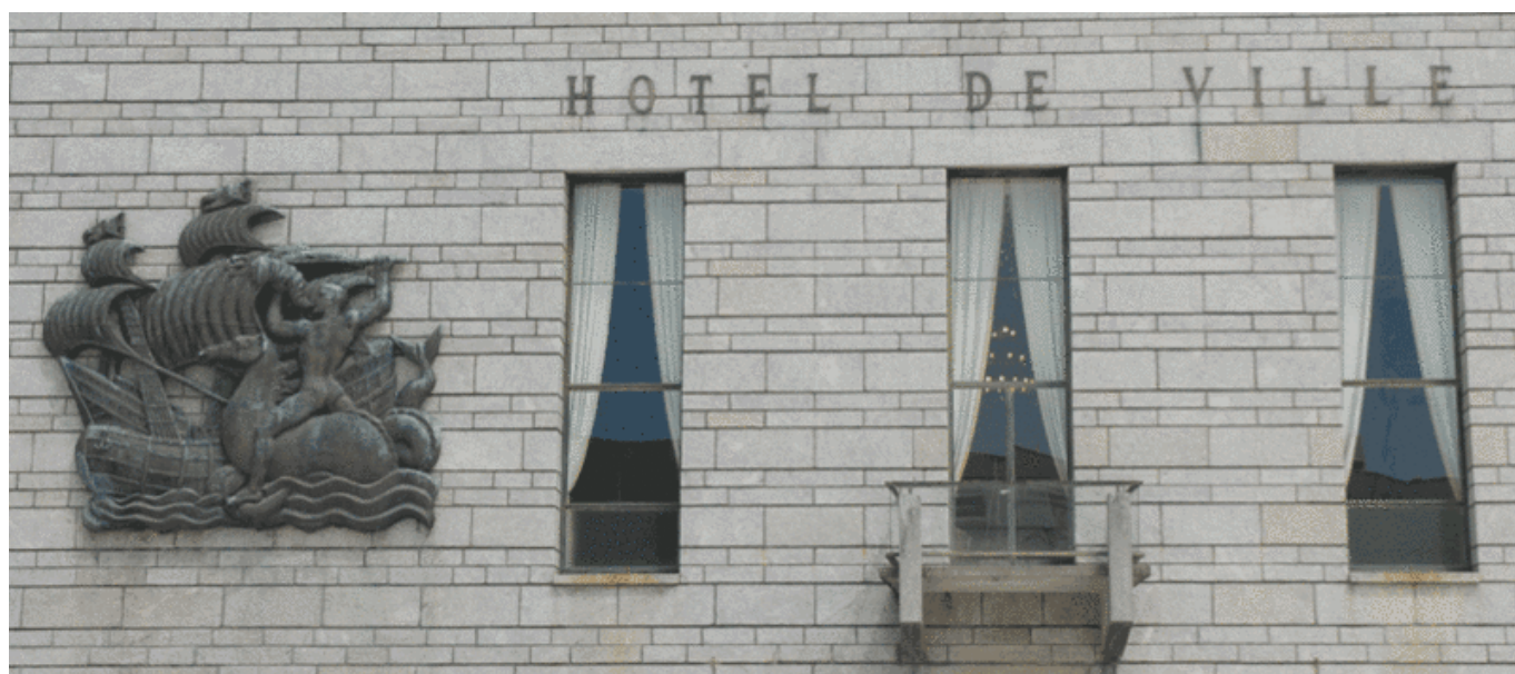
Situation en façade de l'hôtel de ville
