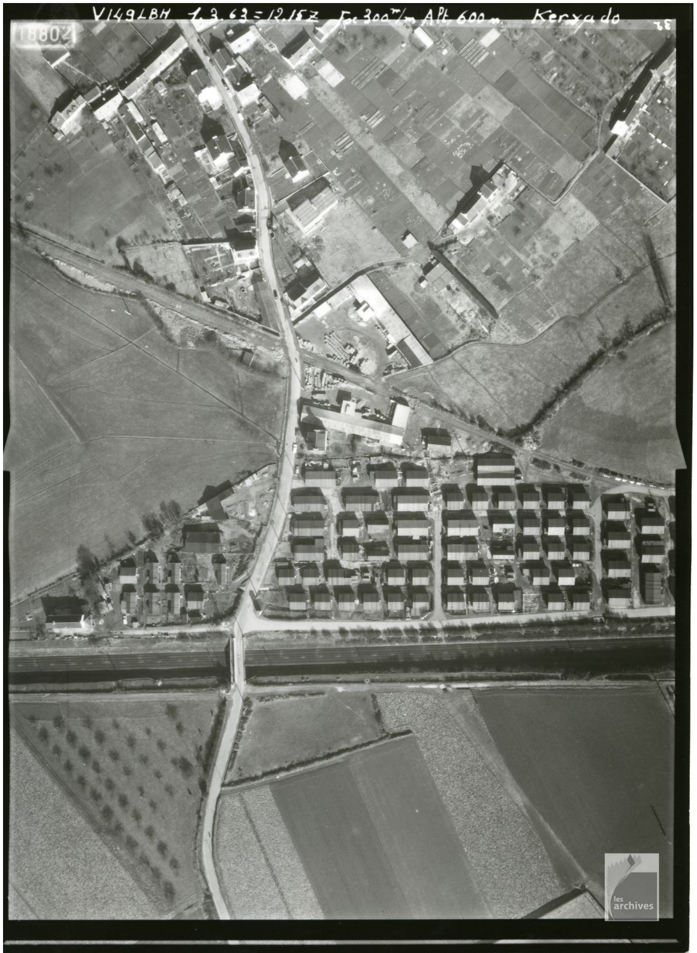
De nombreuses baraques de la cité Jean Le Maux sont assemblées par cette dernière. Ce sont des baraques de type Morosini, 10 m x 10 m, soit des logements de 4 pièces. Pour se
