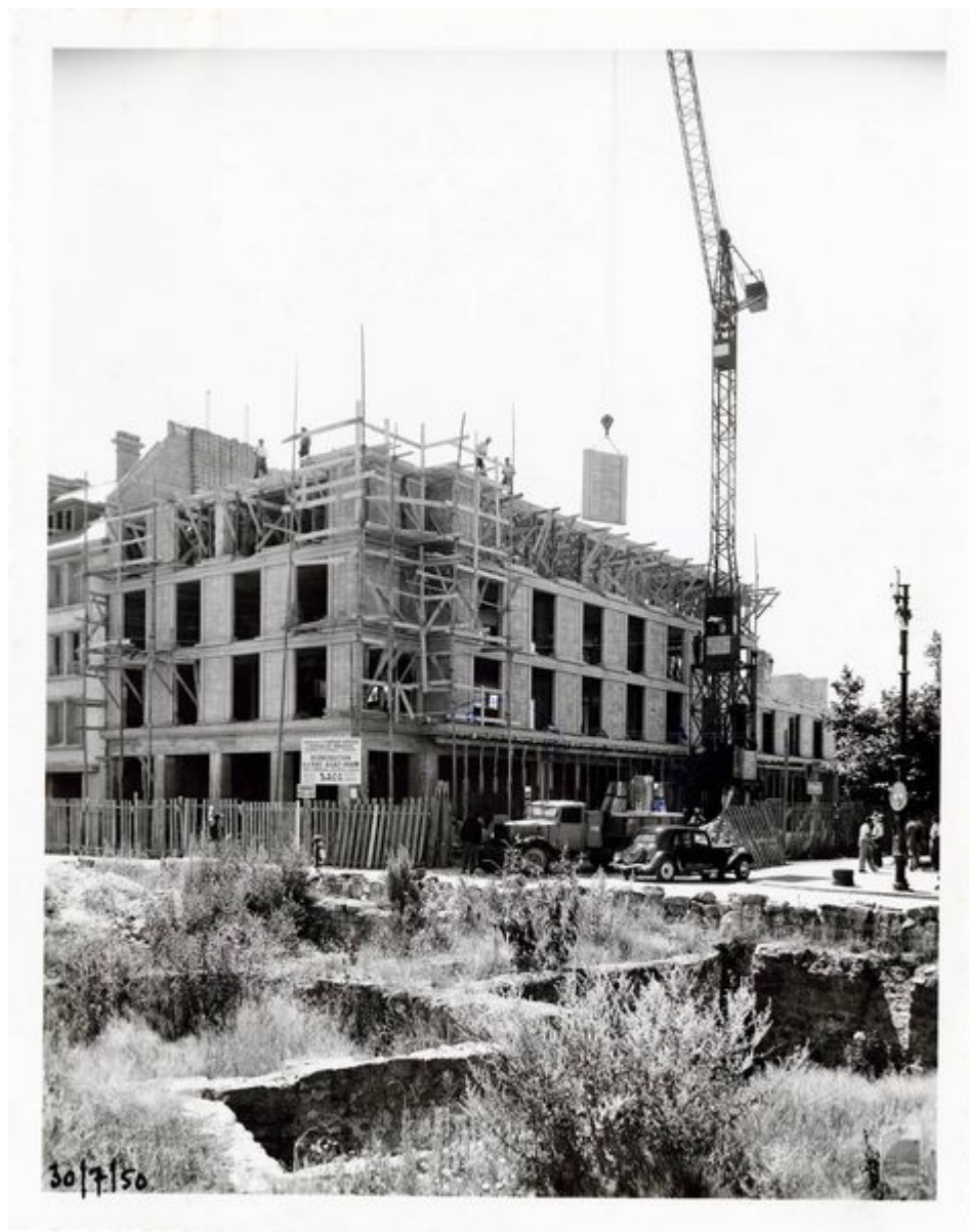
Reconstruction d'un immeuble place Alsace-Lorraine - 5Fi554
