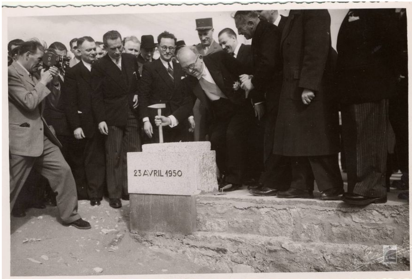
Vincent Auriol scellant la première pierre de l'îlot 153 - 5Fi9108
