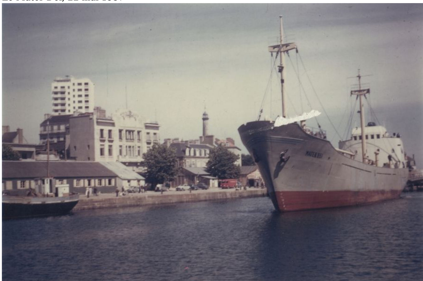
Le Mater Dei dans le bassin à flot
